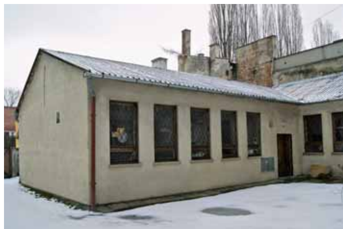
Budova tlačiarne dnes
